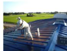
⑤錆処理剤塗布
