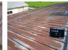
④下地処理完了
