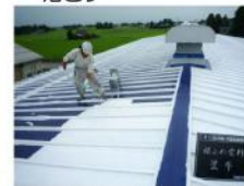
⑥錆止め塗料塗布
