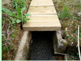
清水集落 水路幅300mm×板厚50mm
