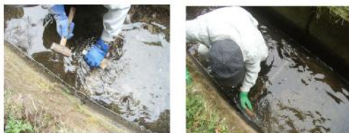
欠落した目地を除去して隙間をつくり、ブラシやジェット水で汚れを取ります
